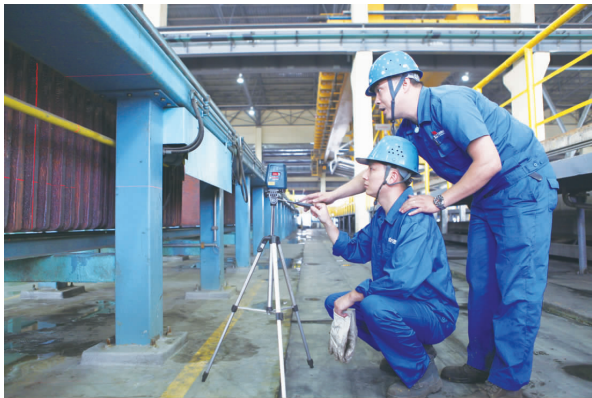
▲10月2日,在冶炼厂“30万吨”项目生产现场,职工用红外水平测试仪测量阳极板,确保阳极板的机组通过率 刘欣杰 摄
